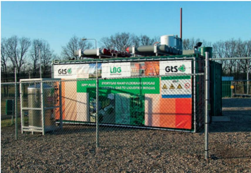
Abb. 3: Im niederländischen Weert wurde auf der Deponie eine GPP®plus-Anlage installiert, mit der 30 Nm<sup>3</sup>/h Biogas zu LBG verarbeitet werden können.
